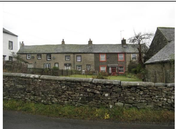
Nos. 1-4 Bampton Grange.
